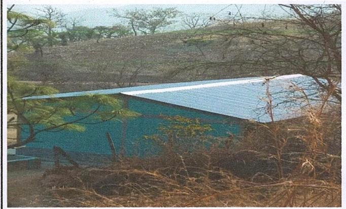
Foto 2: SE CAMBIO EL TECHO POR LAMINAS TROQUELADAS.
